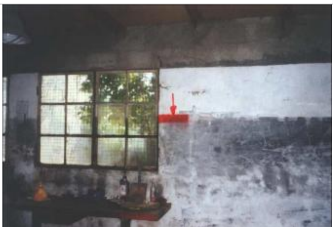
Mur intérieur de l'entrepôt
