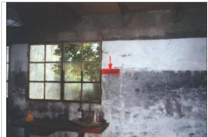
Mur intérieur de l'entrepôt
