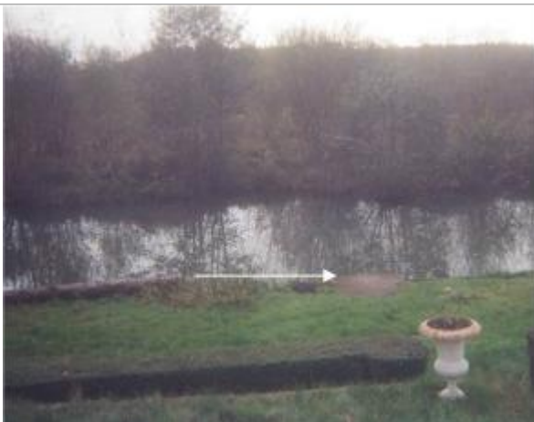
L'eau est montée d'environ 2 cm au-dessus du ponton (Source: SAFEGE)
