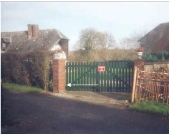
Eau montée jusqu'en haut de la quatrième brique du pilier du portail d'entrée (Source: SAFEGE)
