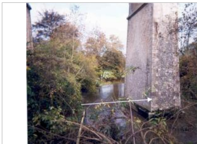
Niveau d'eau monté en haut de la troisième pierre sur le pilier central (Source: SAFEGE)
