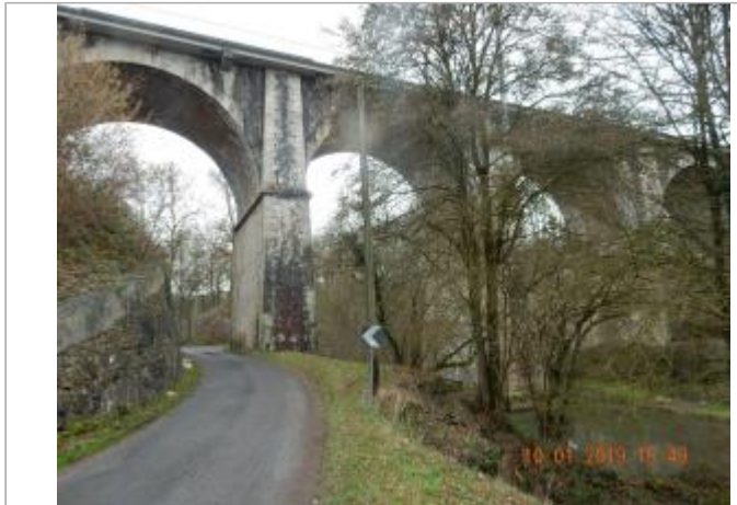
Vue sur le viaduc depuis l'aval (source : SPC SACN)
