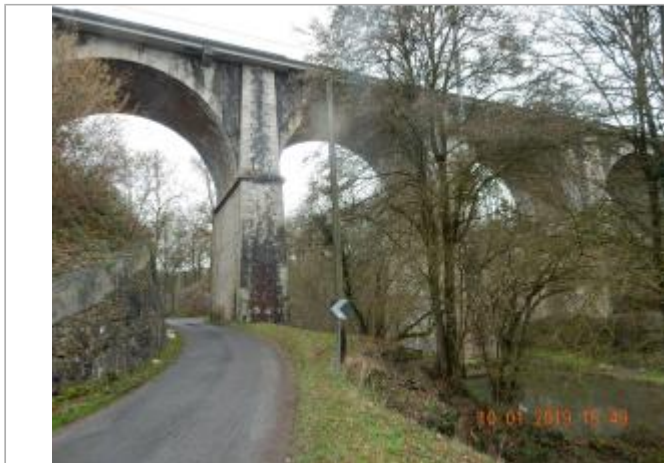
Vue sur le viaduc depuis l'aval (source : SPC SACN)
