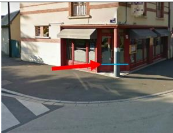
10 cm au-dessus du seuil de la porte d'entrée. (Source: EGIS)
