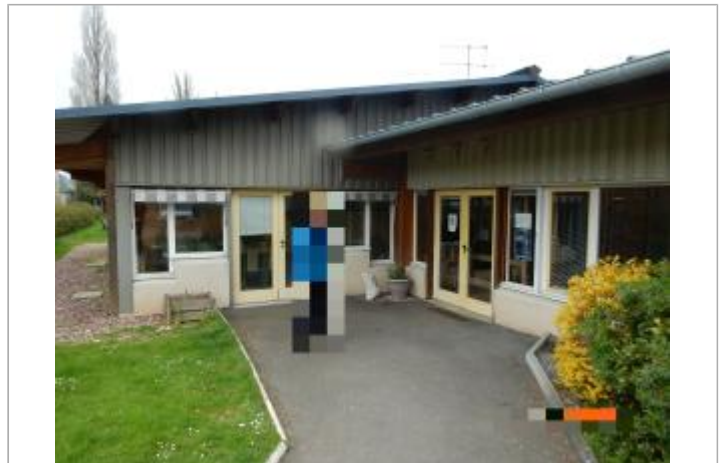
Accueil des Ateliers de l'IME, 28 rue Georges Clémenceau (Source: SPC SACN)
