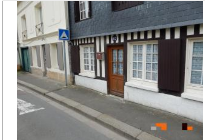
Habitation au n°47 de la rue Thouret (photo SPC SACN).
