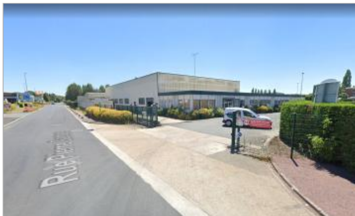
Entreprise de transport routier, Rue Pierre Gamarre
