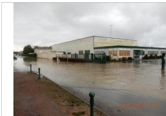
Niveau d'eau juste en dessous du sommet du terre-plein soutenant le portail d'entrée. Entrée du local d'accueil pas touchée (Source: SPC SACN)
