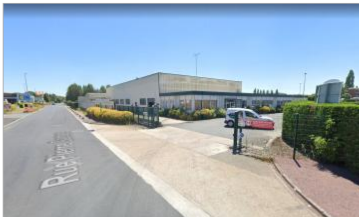
Entreprise de transport routier, Rue Pierre Gamarre
