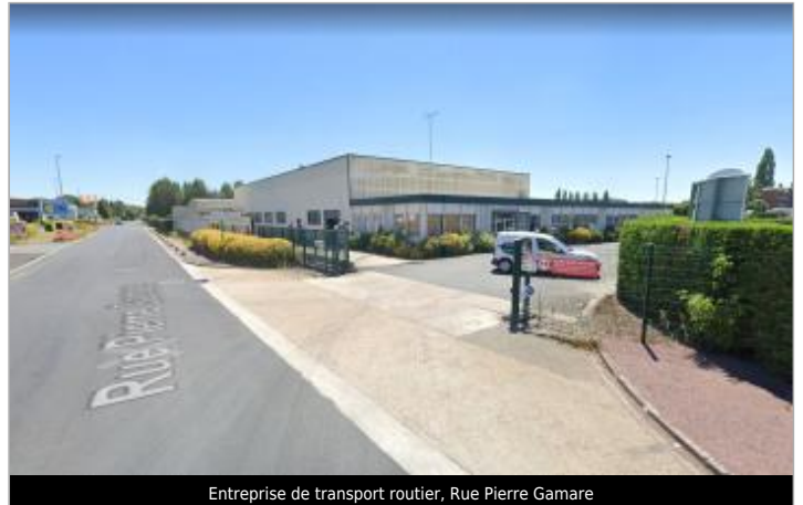
Entreprise de transport routier, Rue Pierre Gamarre
