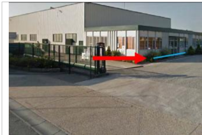
30 cm au-dessus du seuil de la porte d'entrée du local d'accueil (Source EGIS)
