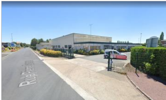
Entreprise de transport routier, Rue Pierre Gamarre
