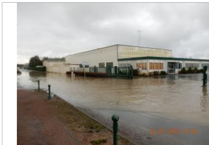
Niveau d'eau juste en dessous du sommet du terre-plein soutenant le portail d'entrée. Entrée du local d'accueil pas touchée (Source: SPC SACN)
