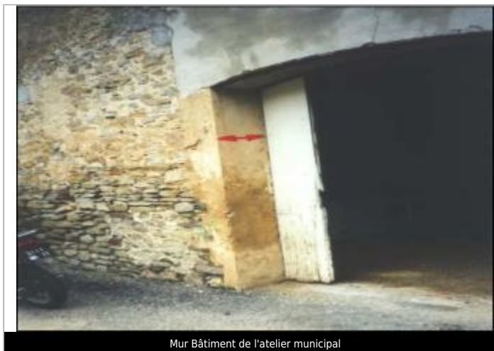
Mur Bâtiment de l'atelier municipal
