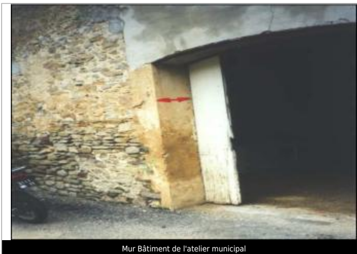
Mur Bâtiment de l'atelier municipal
