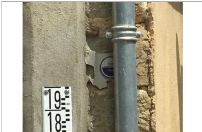
repère au niveau de l'échelle
