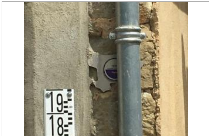
repère au niveau de l'échelle
