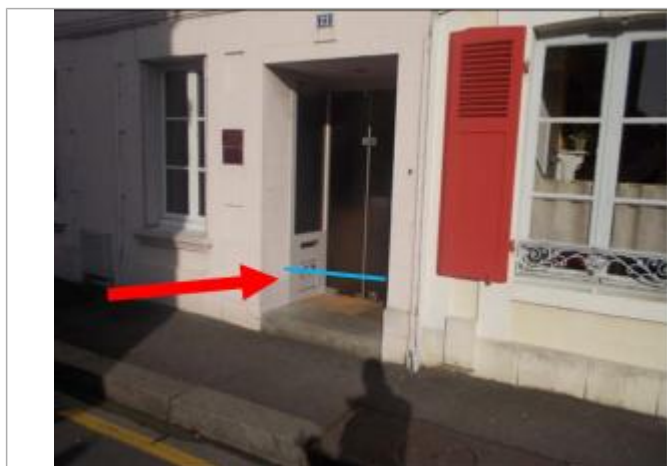
60 cm au-dessus du seuil de la porte d'entrée (Source: EGIS)
