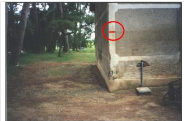
mur du bâtiment
