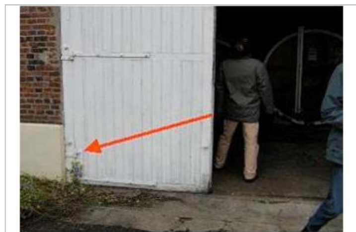
Au niveau du premier gond de la salle des cuves (Source: ISL Paris)
