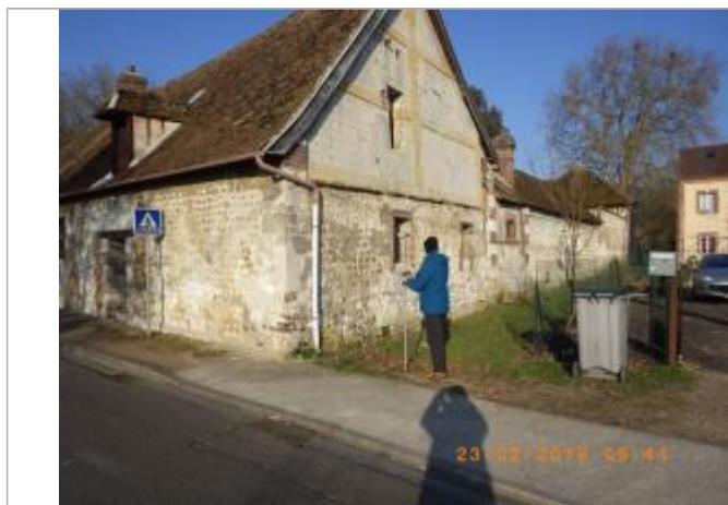
Laissez d'inondations de la crue de février 2018 (photo SPC SACN)
