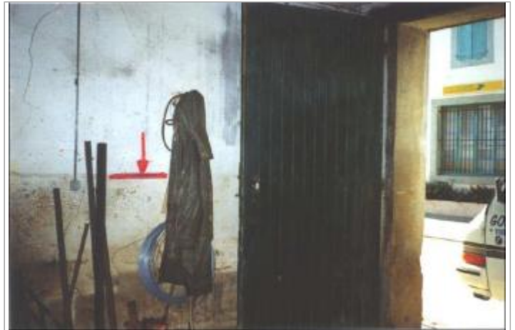
Trait peinture à l'intérieur d'un garage
