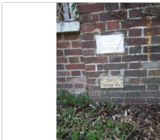
Repères des crues de 1910 et 1945 (photo SPC SACN)
