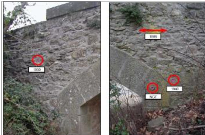
Parement du pont amont
