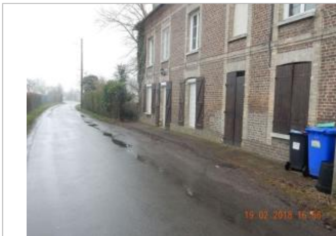
48 rue des Ecluses (photo SPC.SACN)
