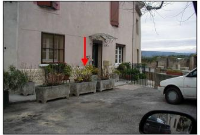
Mur de parement façade entrée maison
