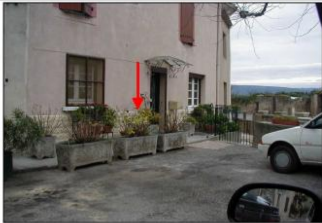
Mur de façade - Niveau haut du parement
