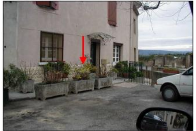
Mur de parement façade entrée maison
