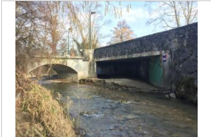
Gaillard, Pont de Souville
