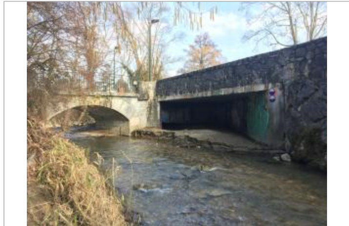
Gaillard, Pont de Souville
