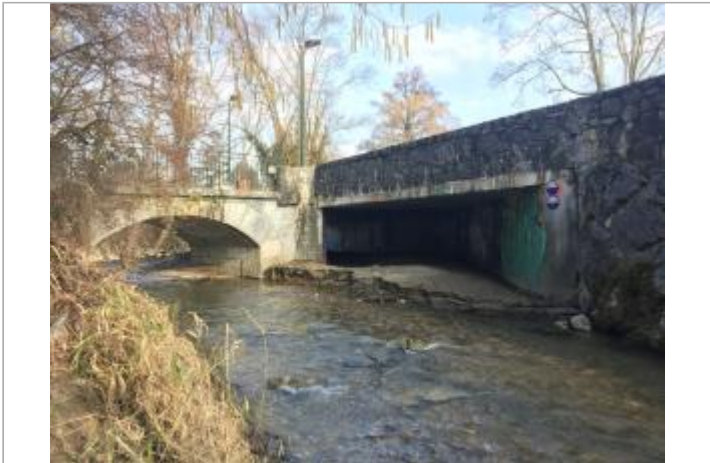
Gaillard, Pont de Souville
