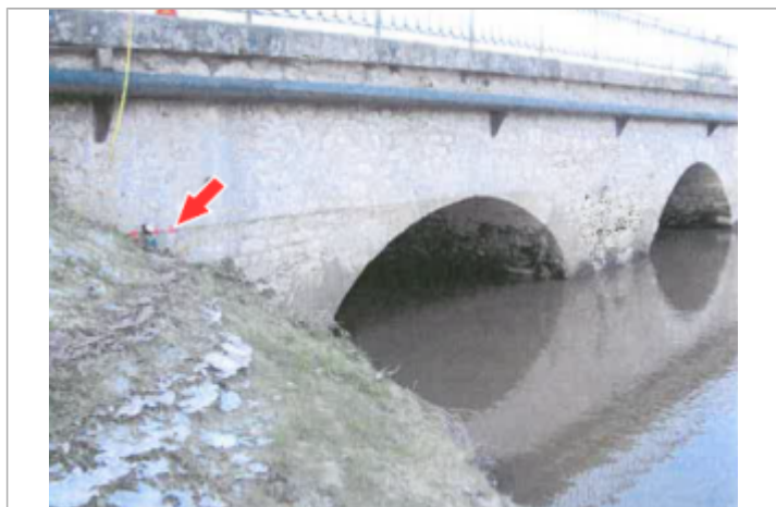
Site et repère (photo recensement d'origine)
