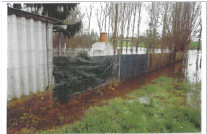
Site pendant la crue (photo recensement d'origine)
