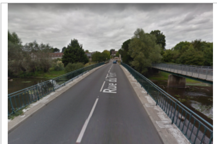
Vue du site (source : Google Street View, septembre 2017)
