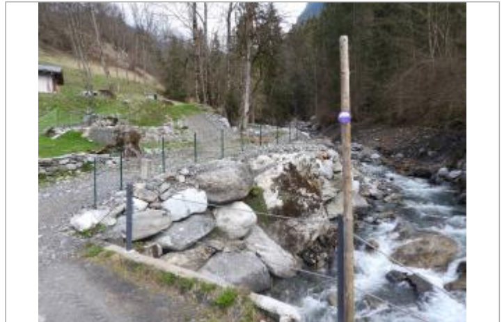
Passerelle au dessus du Souay
