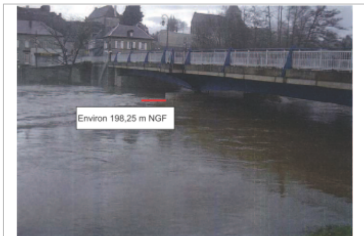
Site et repère pendant la crue (source : ISL Ingénierie et mairie de Cercy-la-Tour)
