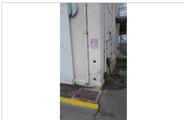
Bâtiment Expo'Seudre, Chenal de La Trembalde
