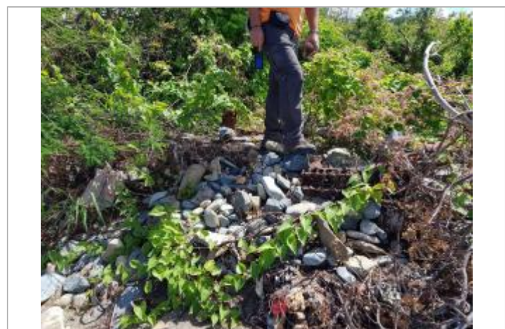
Vue de la PHE - Auteur : Cerema
