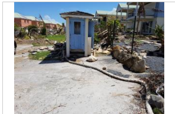
Vue de la PHE - Auteur : Cerema
