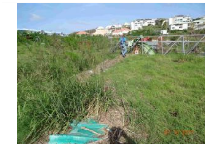
Vue de la PHE - Auteur : Cerema
