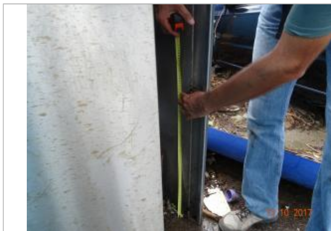
Vue de la PHE - Auteur : Cerema
