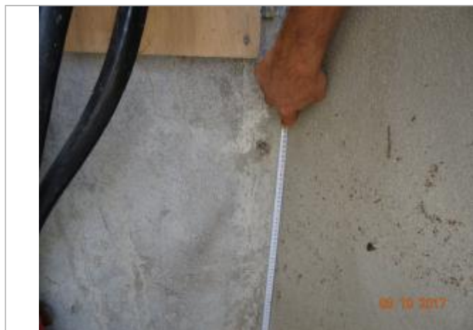
Vue de la PHE - Auteur : Cerema
