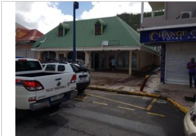
Vue du site - Auteur : Cerema
