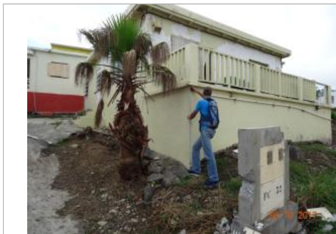
Vue de la PHE - Auteur : Cerema
