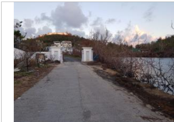
Vue du site - Auteur : Cerema
