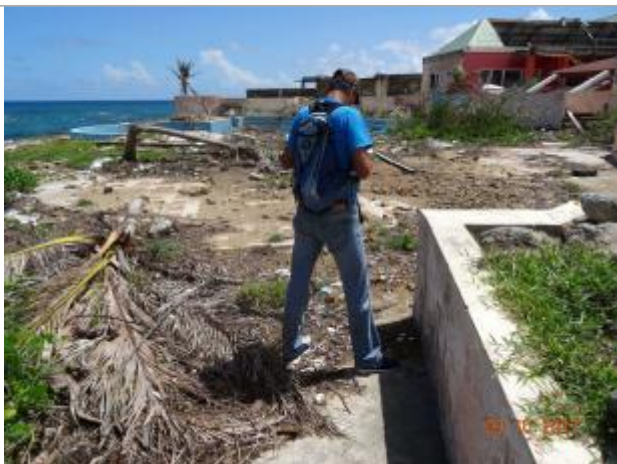
Vue de la PHE - Auteur : Cerema
