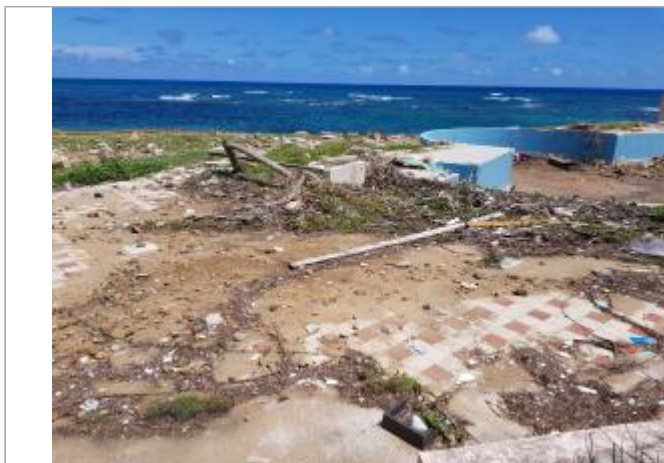
Vue du site - Auteur : Cerema
