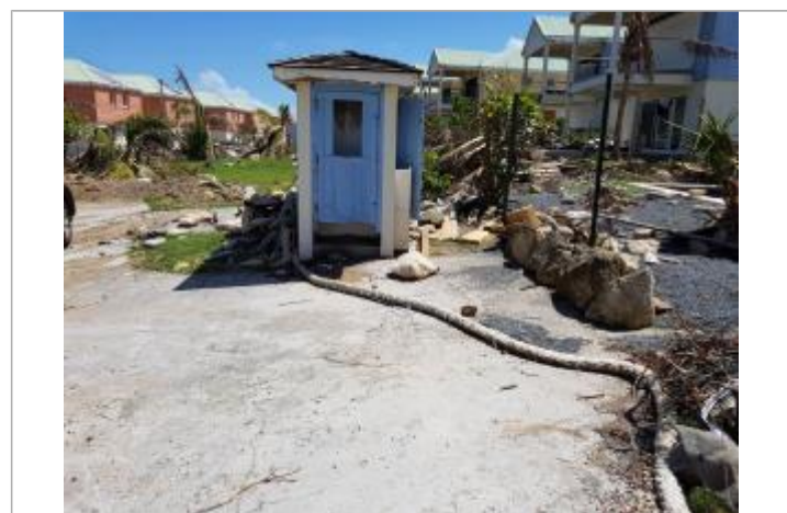
Vue de la PHE - Auteur : Cerema
