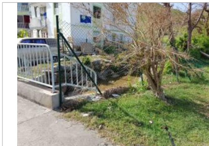
Vue de la PHE - Auteur : Cerema
