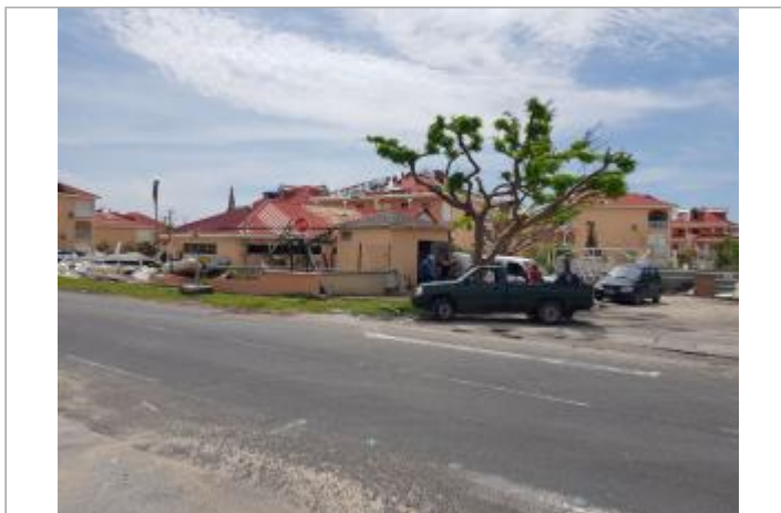
Vue du site - Auteur : Cerema
