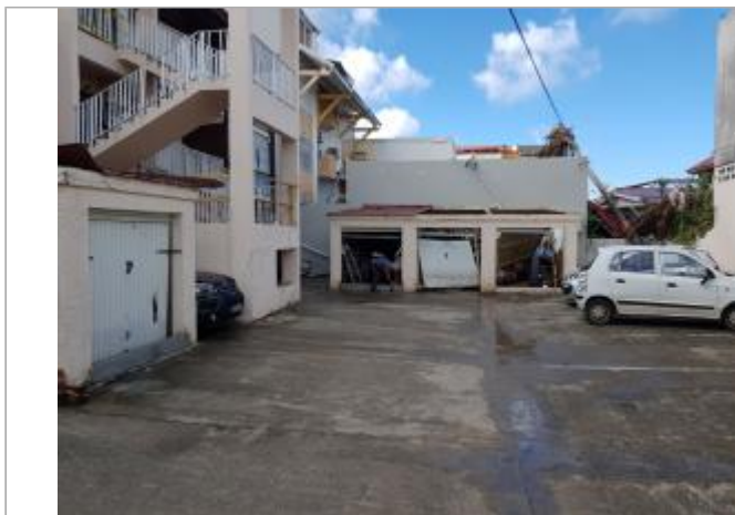
Vue du site - Auteur : Cerema
