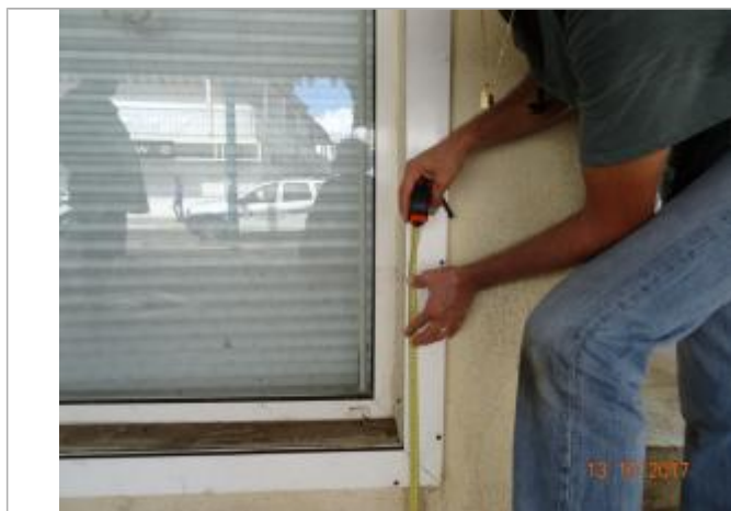
Vue de la PHE - Auteur : Cerema
