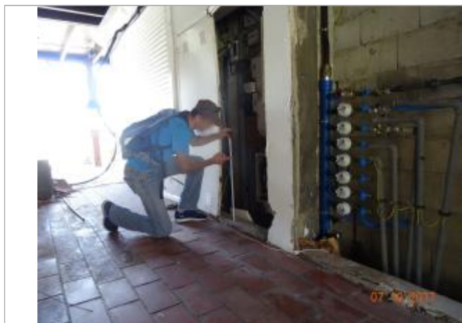
Vue de la PHE - Auteur : Cerema
