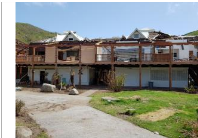
Vue du site - Auteur : Cerema
