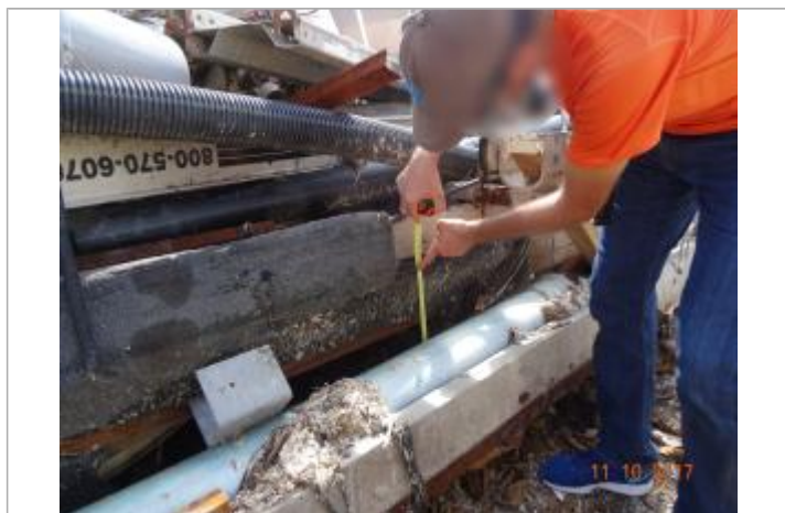
Vue de la PHE - Auteur : Cerema
