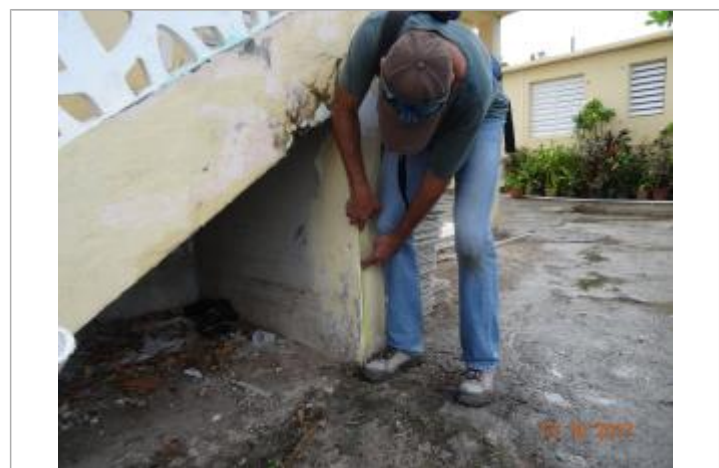
Vue de la PHE - Auteur : Cerema
