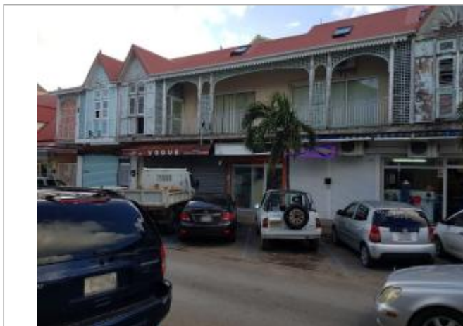
Vue du site - Auteur : Cerema
