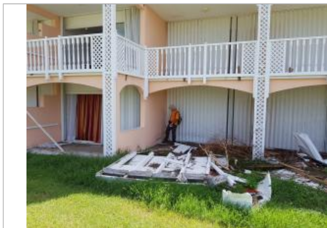
Vue de la PHE - Auteur : Cerema
