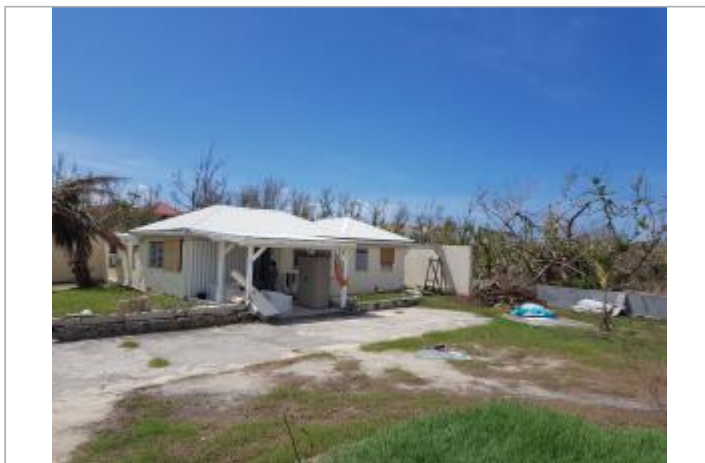
Vue du site - Auteur : Cerema
